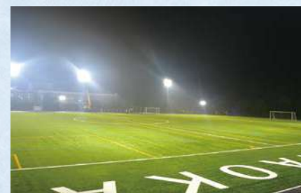
夜間照明付き総合グラウンド
